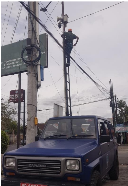
Gambar III.10 Pemasangan CCTV
